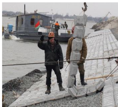
Рис. 13. Крепление гибкими бетонными матами
