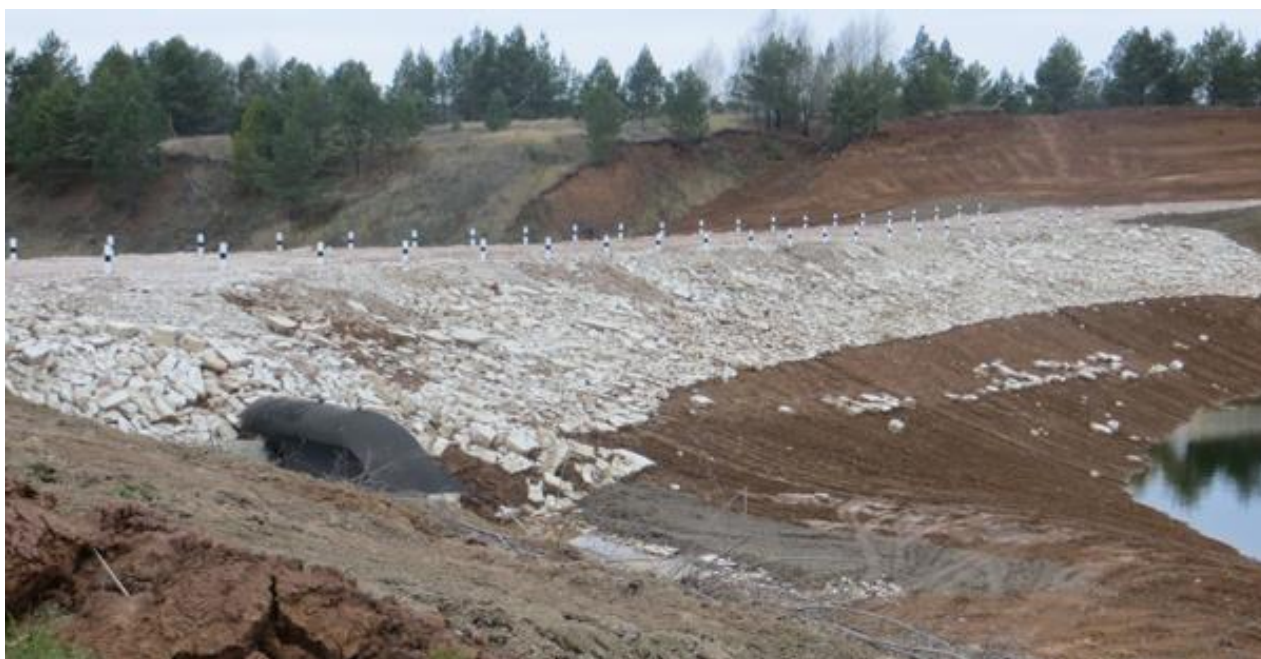
Рис. 12. Пример укрепления берега с использованием каменной наброски
