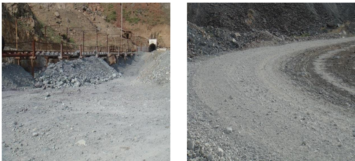
Рис. 2. Состояние дороги на ЧРУ
