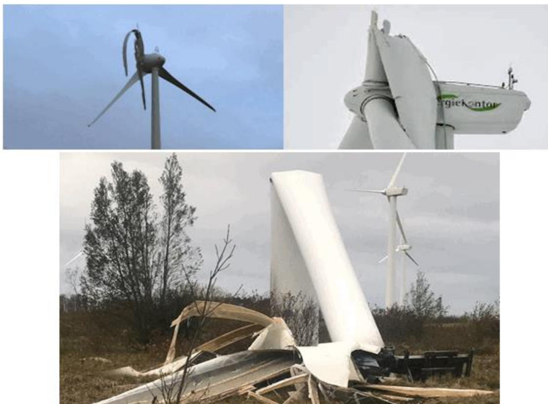
Рис. 3. Разрушенные наземные ветровые электростанции
