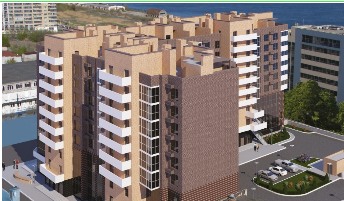
Рис. 4. Архитектурный облик объекта
