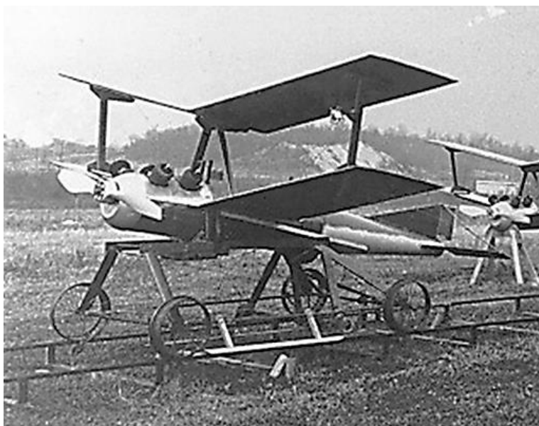
Рис. 2. Воздушная торпеда «Жук» Кеттеринга, фото из открытых интернет-источников [3]
