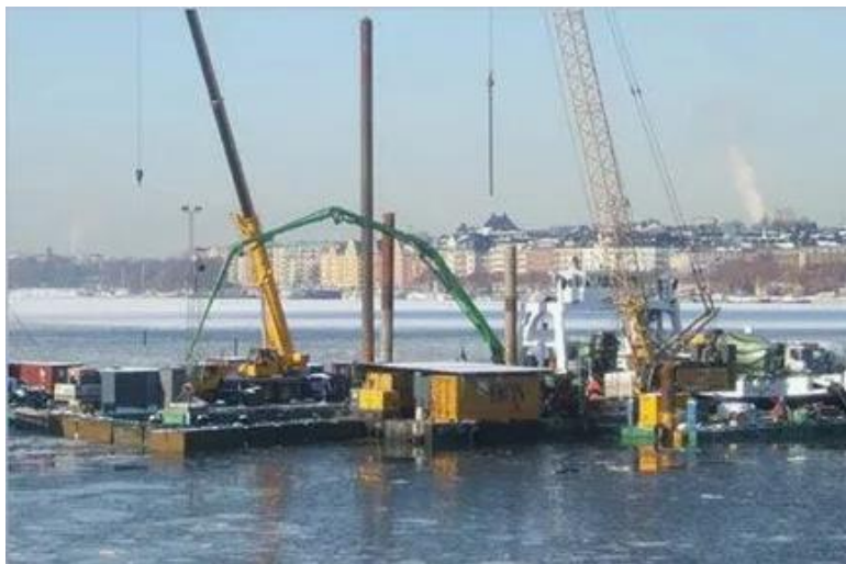
Рис. 1. Подготовительные работы для подводного бетонирования
