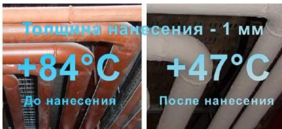
**Рис. 2. Пример теплоизоляции «до нанесения»
