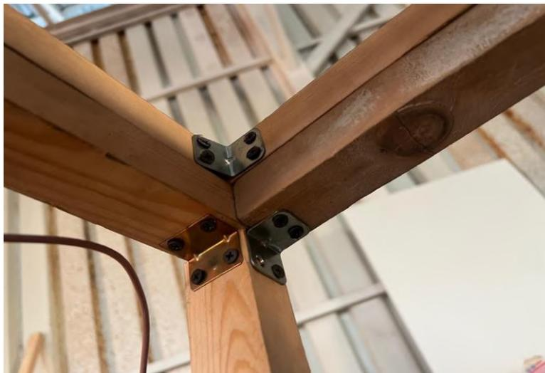
**Рис. 2. Повышение прочности рамы**
