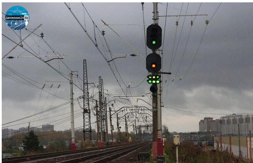
Рис. 4. Пример трёхзначной и четырёхзначной автоблокировки
