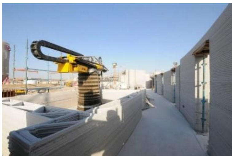
Рис. 2. Процесс возведения дома с помощью печати
