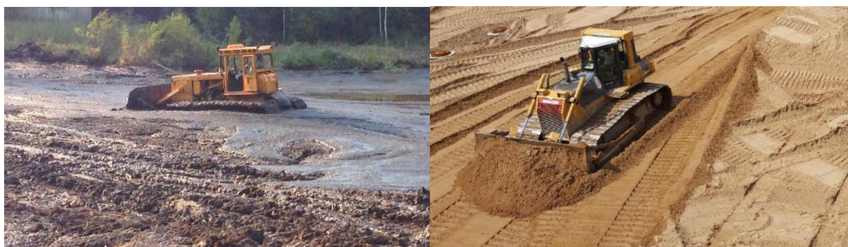
Рис. 2. Работа бульдозеров на переувлажнённом и сухом грунте
