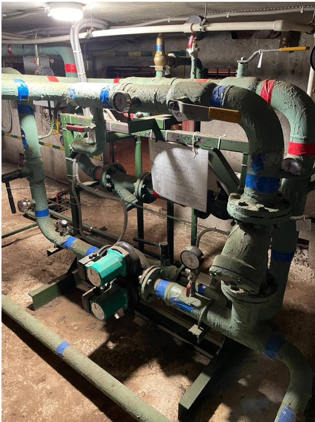
Рис. 1. Смесительный узел погодного регулирования
