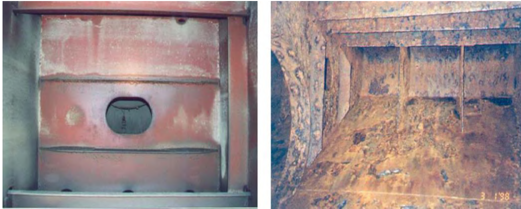
Рис. 1. Балластные танки двух судов одинакового возраста 13 лет: слева покрытие нанесено с соблюдением стандарта, справа – с нарушением технологии
