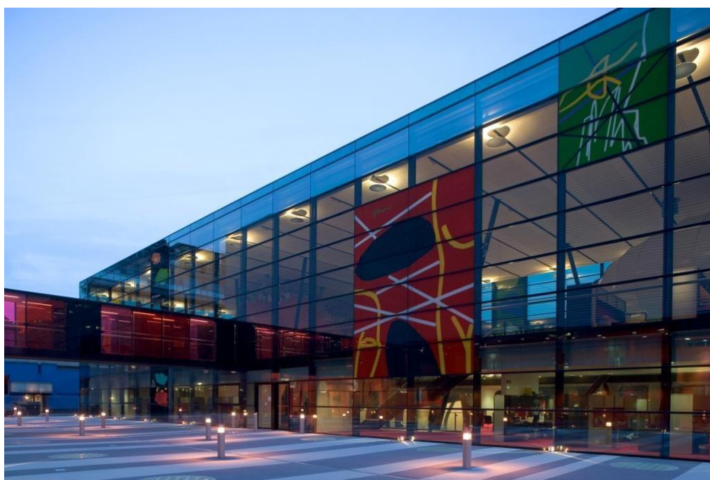
Рис. 1. Здание Центра «Близард» Института клетки и молекулярных исследований
