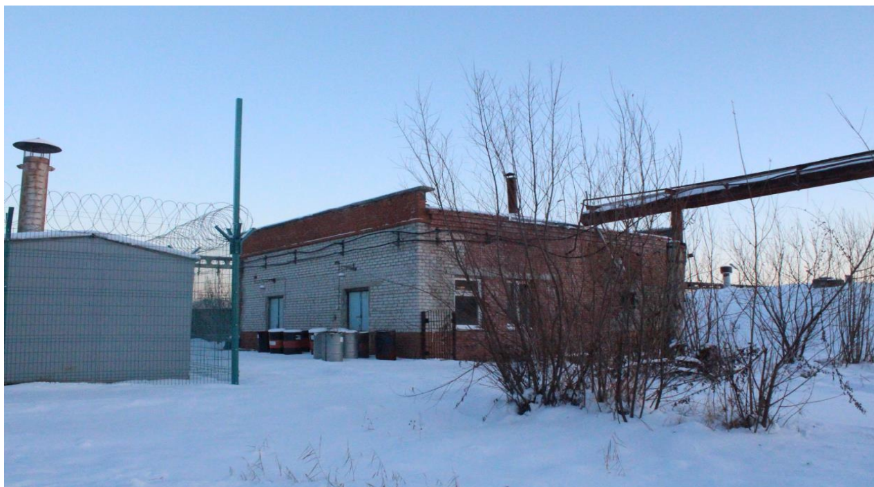
Рис. 1. Здание канализационной насосной станции
