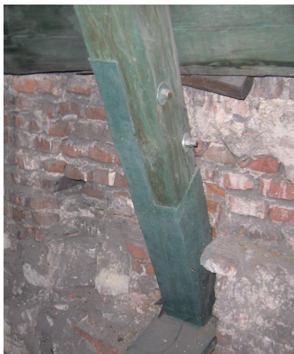
Рис. 2. Замена опорной зоны стропил на новую деревянную деталь
