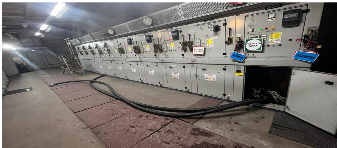
Рис. 1. Замена силовых кабелей на ТП «ЖДЦ» [6]
