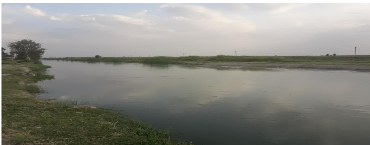
Рис. 2. Общий вид участка строительства и верхний бьефы транзитного перепада ПК 130+10
