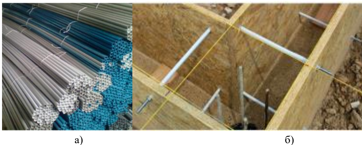
Рис. 2. Трубы ПВХ в установленном состоянии:
