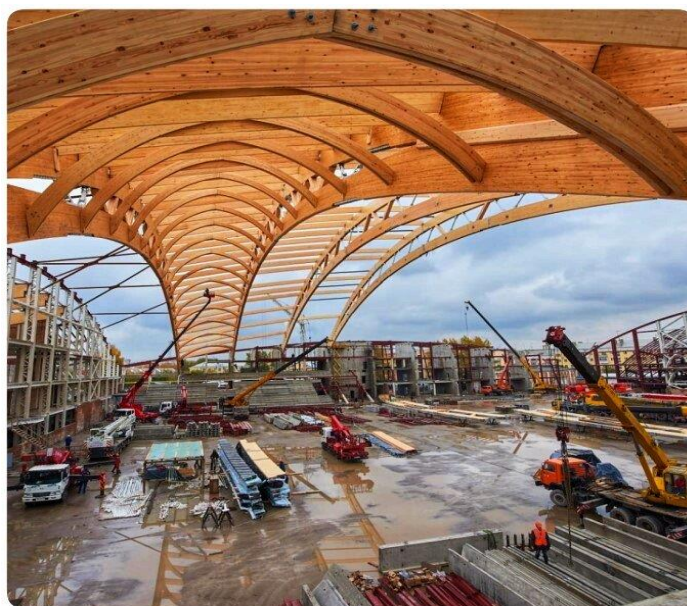
Рис. 1. Купол ледового стадиона в г. Красноярск
