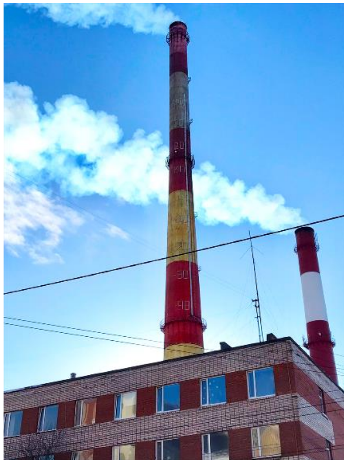
Рис. 1. Вид на Мурманскую ТЭЦ с дымовой трубой высотой 150 метров
