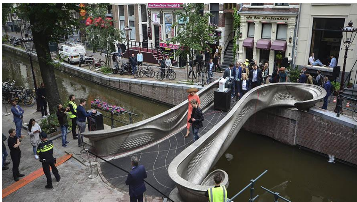
Рис. 4. Мост, построенный с помощью 3D-технологий в Нидерландах
