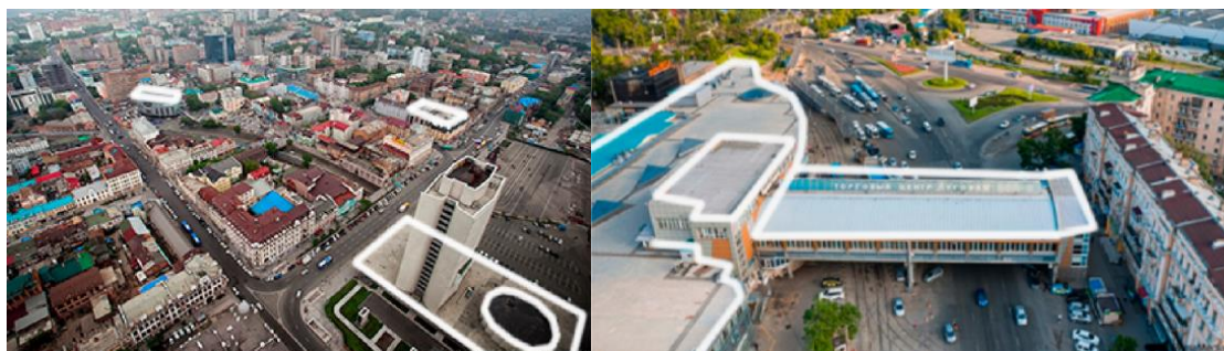
Рис. 9. Здания с большой плоскостью кровли
