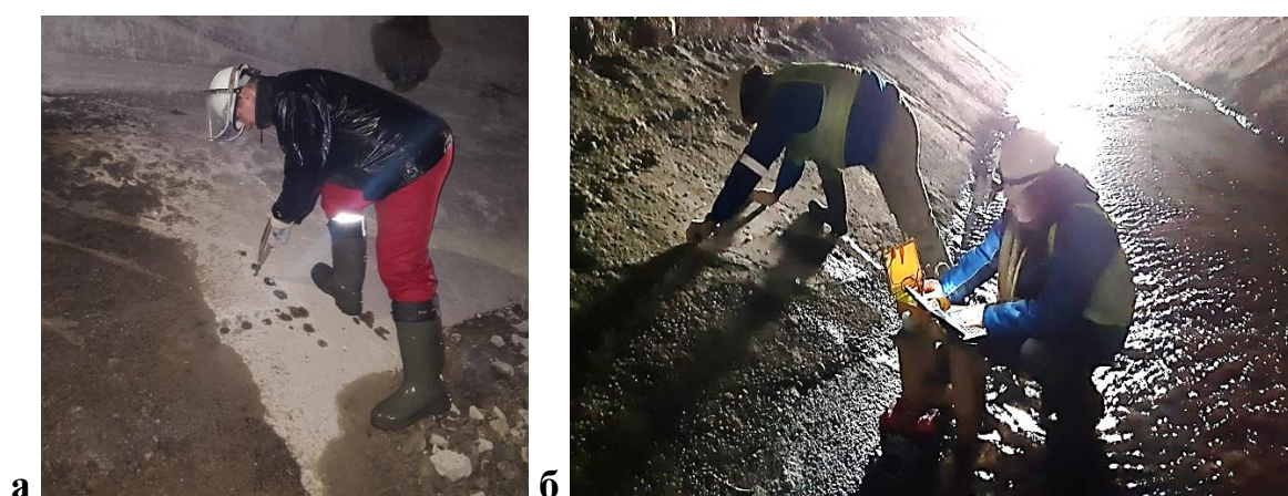
Рис. 4. Примеры проведения исследований бетона в нижней фаске труб Шамкирского водосброса: а - методом упругого отскока, труба № 2; б – ультразвуковым методов в трубе № 1
