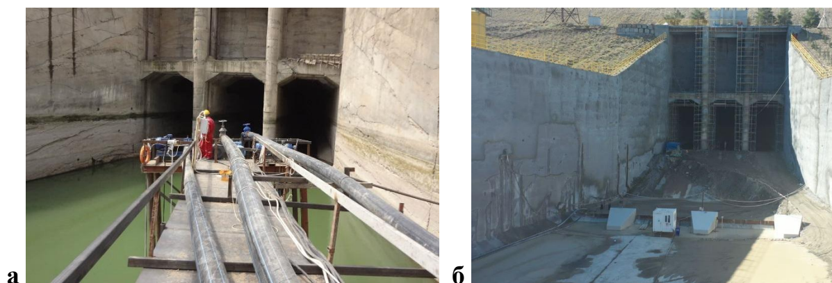
Рис. 3. Состояние выходного участка трёхочкового Шамкирского водосброса до (а) и во время (б) подготовки водобоя к реконструкции (фото Azerenerji OSC)
