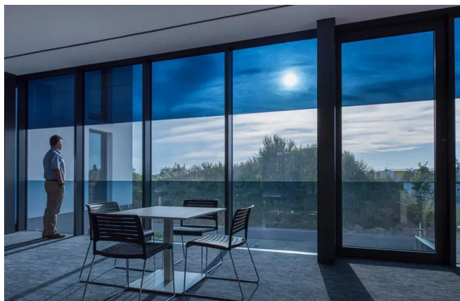
Рис. 2. Панорамные электрохромные стекла в режиме автоматического затемнения для защиты от солнечной инсоляции
